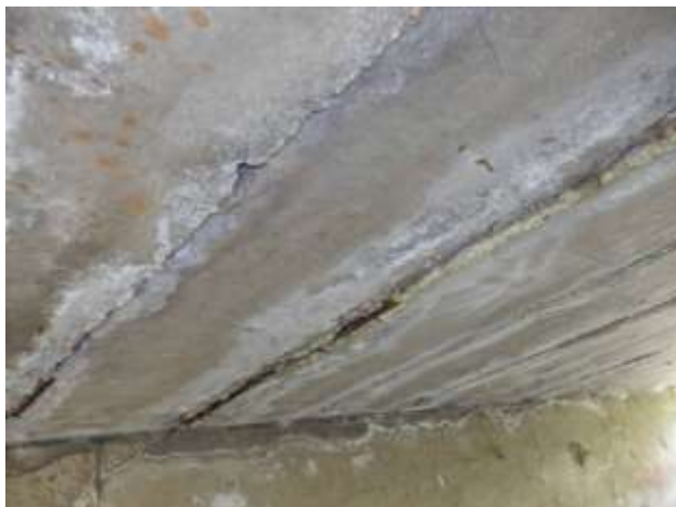
Vnitřní část NK - zatékání spárami mezi nosníky
