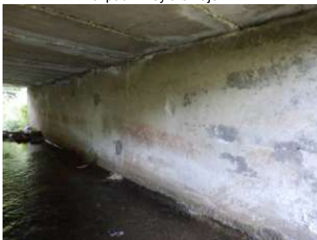
Opěra 2 - čelní plocha - omítka. Výluhy v úložné spáře.
