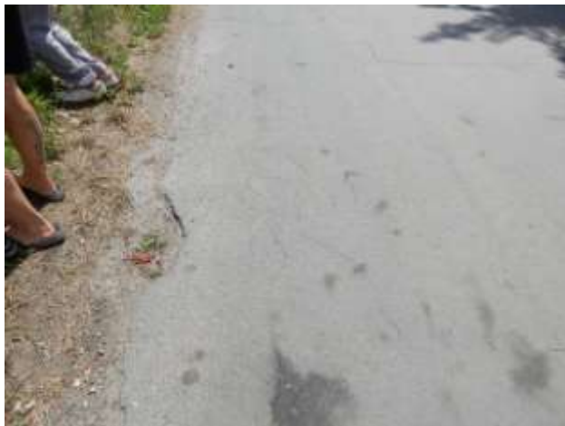
Trhliny ve vozovce
