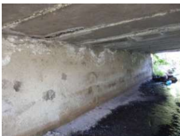
Opěra 1 - čelní plocha - omítka. Výluhy v úložné spáře.
