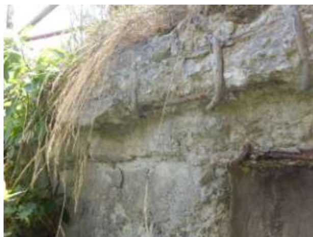
Opěra 1 vpravo - detail. Rozpad betonu na boku opěry. Rozpad římsy a okraje NK.
