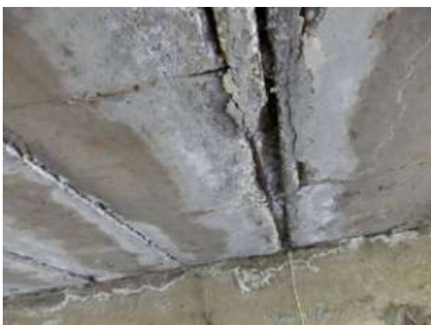
Porušený beton spáry a okraje nosníků
