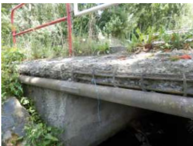
Levá římsa a bok NK (překrytý chráničkou)
