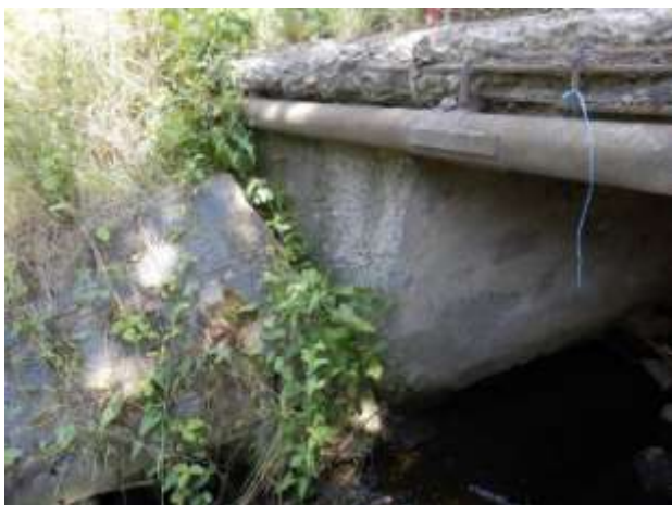
Opěra 2 vlevo - detail. Rozpad betonu na boku opěry.
