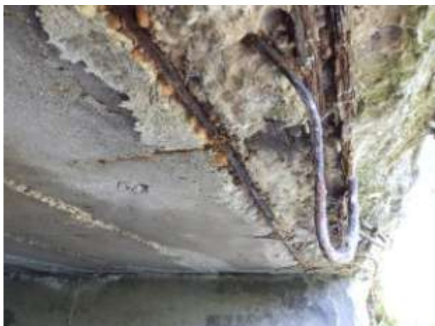
Pravý okraj NK. Rozpad degradovaného betonu, zbožtnalá výztuž.
