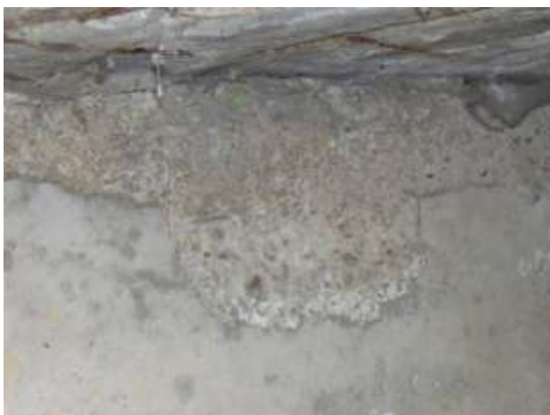
Detail betonu na čelní ploše opěry v místě odpadlé omítky
