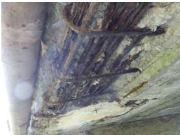
Levý okraj NK. Rozpad degradovaného betonu, zobtnalá výztuž.
